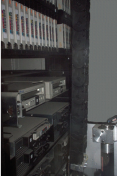
9 Blick in den AML-J Bandroboter im Rechnermuseum der GWDG (links von oben: AIT-3-Kassetten; CD-ROM-Laufwerke; AIT-Laufwerke)
